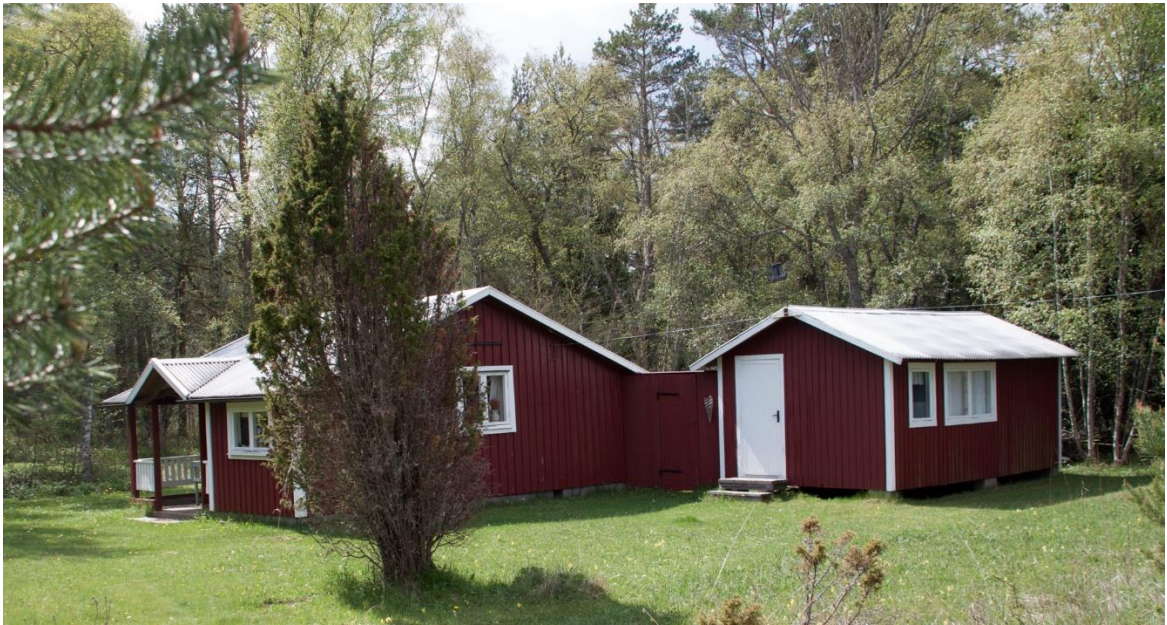
Bild på huset från 2014.
